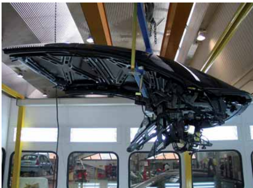
► Retirada del techo con útil específico
